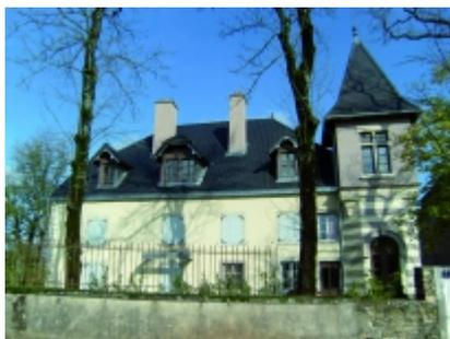
La tuile H10 Huguenot est une tuile grand moule faiblement galbée produite sur le site de St Germer de Fly en Picardie. On la pose à joints droits et , même à faible pente, elle assure une parfaite étanchéité.
